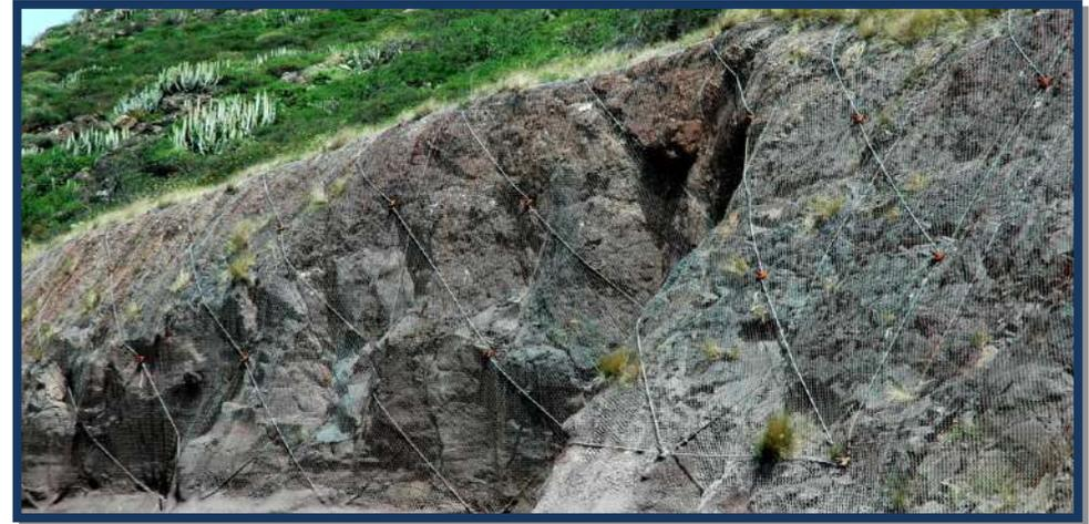
Figura VII.2.4 Sistema mixto de cables y malla.
