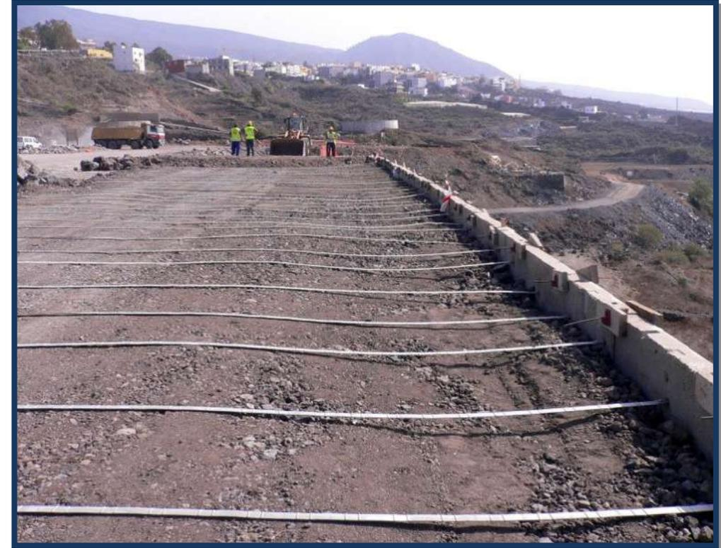
*Figura VII.1.7 Muro de tierra armada en construcción.*
