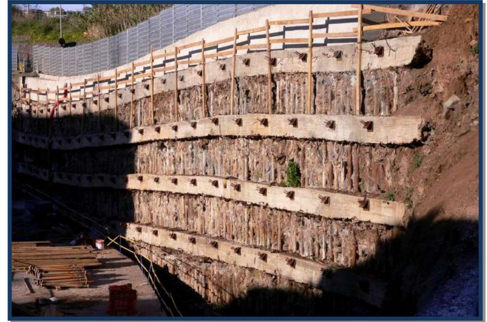
Figura VII.1.5 Anclajes unidos mediante viga de hormigón.
