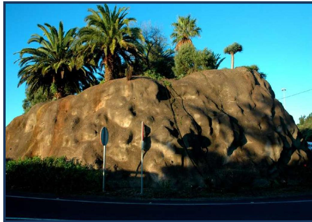
Figura VII.2.5 Hormigón proyectado con pigmentos de coloración.
