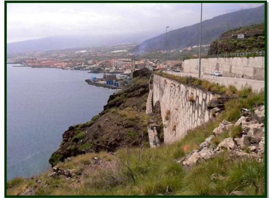
Figura VII.2.12 Muro pantalla.
