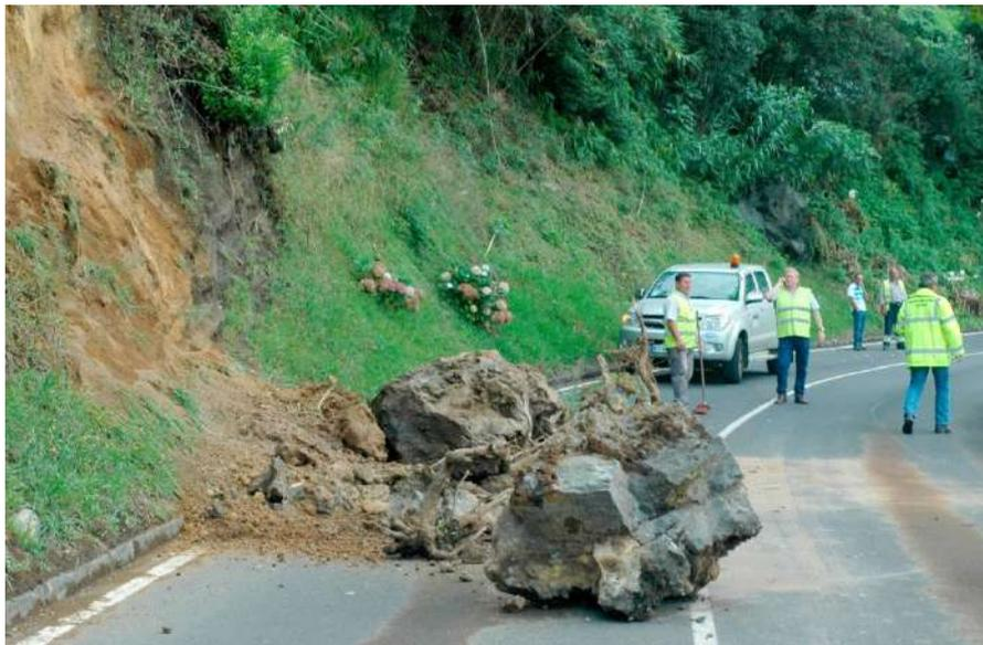
**Figura 1.7.** Desprendimiento en la isla de San Miguel (Açores) después de un episodio de precipitaciones.
