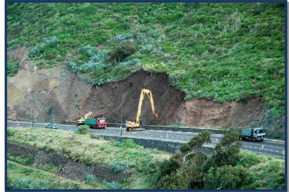
Figura VII.1.1 Retalzado por excavación.
