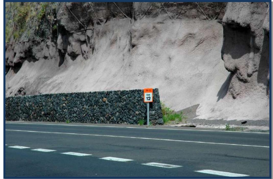
Figura VII.2.6 Hormigón proyectado sin pigmentos de coloración.
