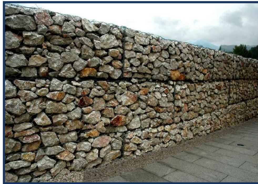
Figura VII.1.6 Muro de gaviones.
