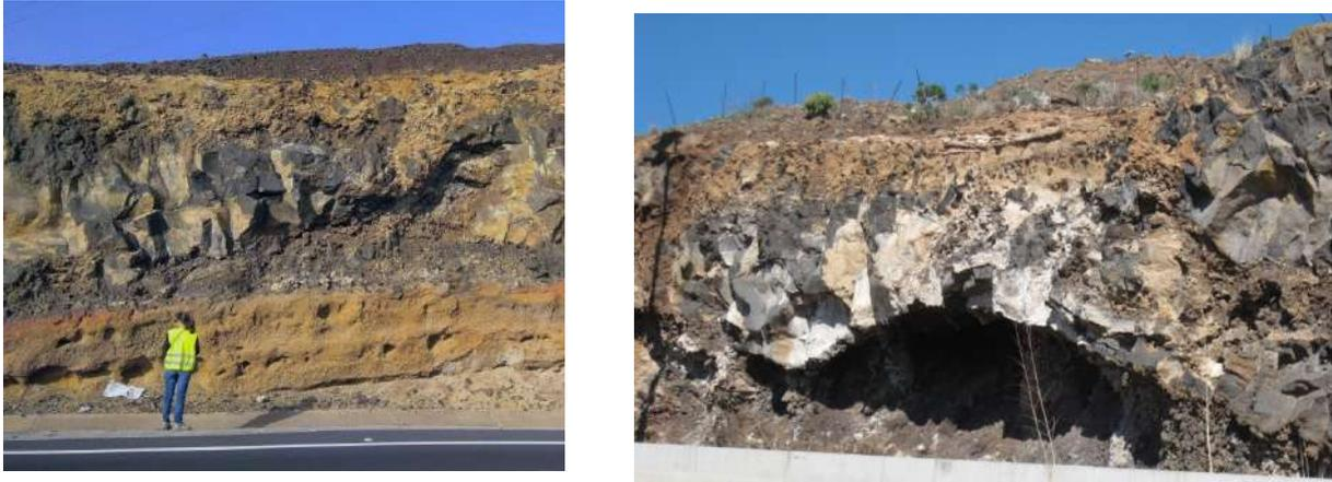
**Figura II.9.** Ejemplos de macizos tipo C. A la izquierda se observa la alternancia de materiales y a la derecha formación de cornisas en el talud.
